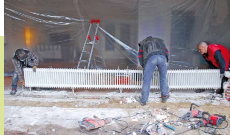
4. Der lange alte Rippen-Heizkörper hatte ebenfalls ausgedient. Und als er dann weg war, konnte man schon die neuen Lichtverhältnisse erahnen.
