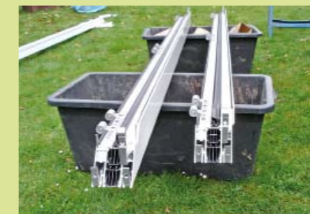
9. Nun beginnt der Zusammenbau des Rahmens für die neue Glas-Faltwand. Dieser besteht aus wärmedämmten Aluminiumprofilen.
