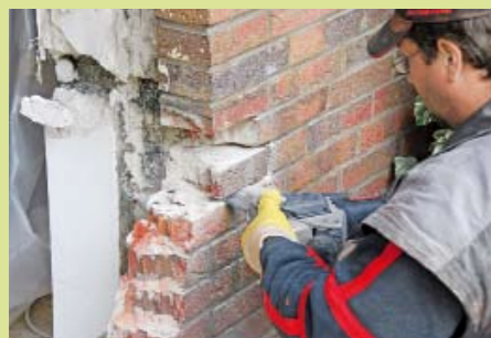
6. Außen wurden die unteren Backsteinreihen mit einer Fugenfräse herausgetrennt, sodass ...
