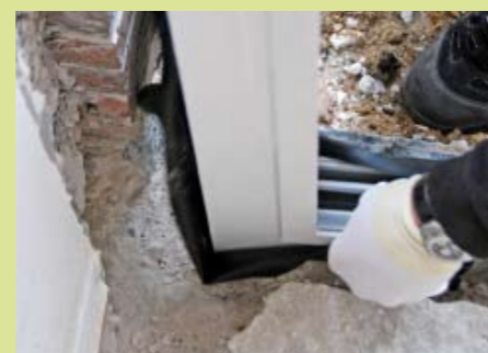
16. Diese wird dann aufgefaltet und der Rahmen in die neu erstellte Laibung eingebracht.
