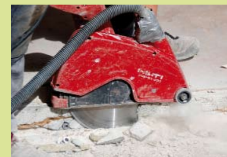
5. Für den Rahmen der neue Türanlage musste auch noch die Estrichkante begradigt werden.
