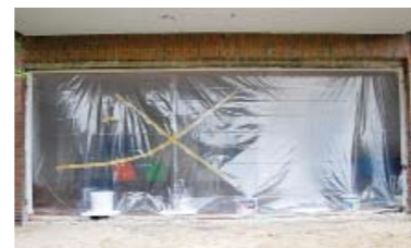
7. ... die Laibungen wieder sauber und verzahnt im Verband neu aufgemauert werden konnten.
