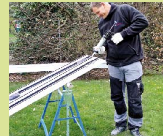
10. Deren Gehrungskanten werden mit einem speziellen Kleber zur Eindichtung vorbereitet.
