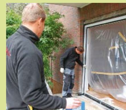
17. Mit einem Baulaser ermittelt man dann die exakte Einbauhöhe bzw. überprüft man den lotrechten Sitz des Rahmens.
