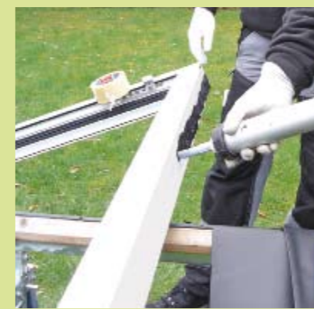
13. Am Schwellenprofil wird auf der Unterseite eine Dichtmasse aufgetragen, mit der ...
