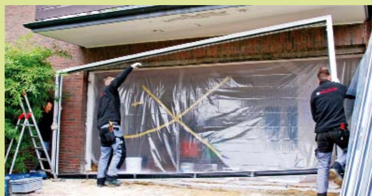
15. Mit zirka 6 x 2 m steht der komplette Rahmen kurz vor dem Einbau. Unten zu sehen noch einmal die noch zum Schutz hochgehaltene Folie.
