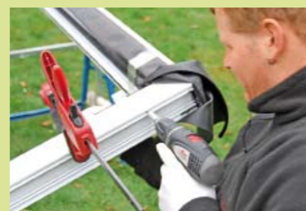
12. Sind die Rahmenteile zusammengesteckt und ausgerichtet, werden die Ecken fixiert.
