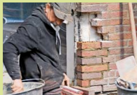
7. ... die Laibungen wieder sauber und verzahnt im Verband neu aufgemauert werden konnten.
