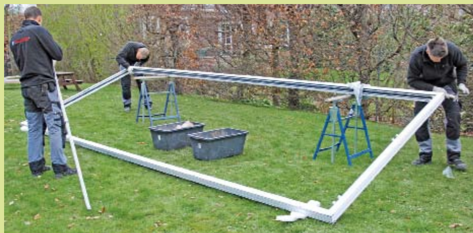
11. Die Verbindung erfolgt über spezielle, nicht sichtbare Eckwinkel, die mit Stiften und Schrauben eine dauerhaft dichte Verbindung der einzelnen Rahmenbauteile ermöglichen.
